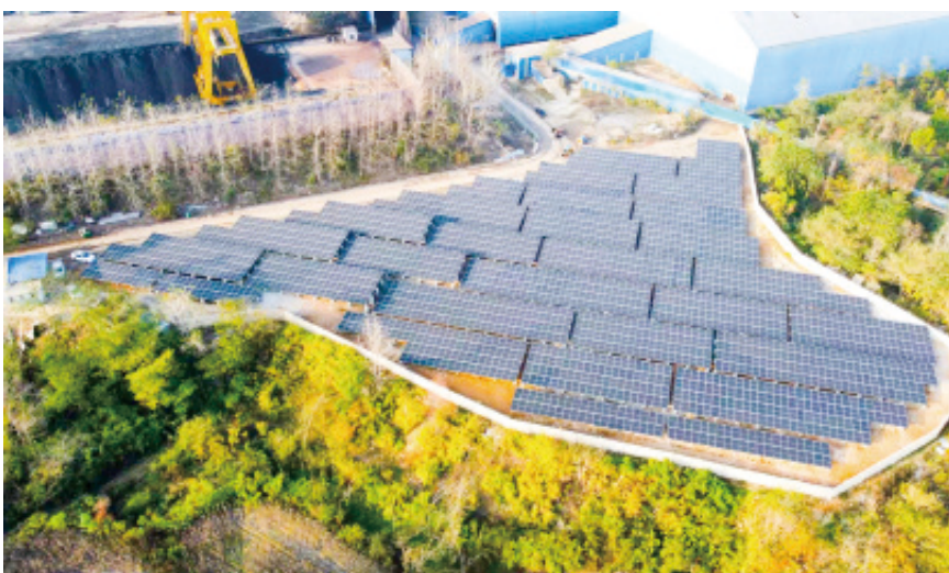
当阳水泥公司光伏发电项目现场
