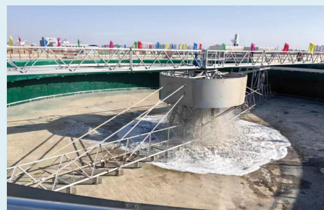
天津津沽污水处理厂三期工程
