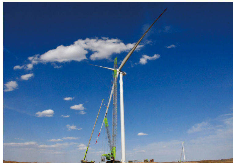
自有800吨履带吊装备在瓜州“光热储能+”项目的运用
