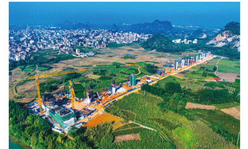
广西横钦高速公路
