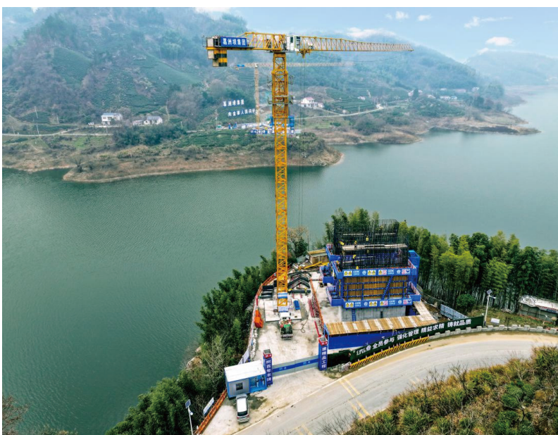
塔吊施工现场
