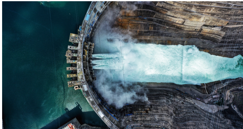
金沙江白鹤滩水电站
