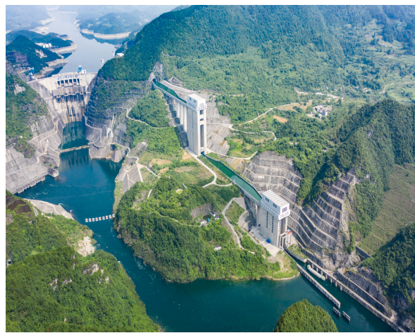
构皮滩水电站
