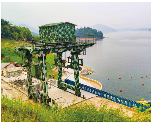
千岛湖配水工程
